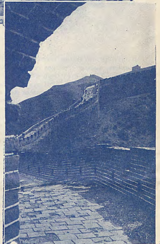
Un coin du mur. A portion of the wall. Mauerpartie.
